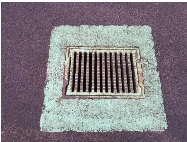
Figur 1. Rännstensbrunn kopplad till dagvatten.
